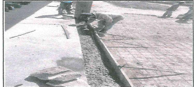
Foto 4: reparacion de la cuneta de concreto
